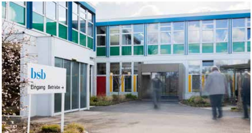
Alle Wege führen zum neuen Eingang.
